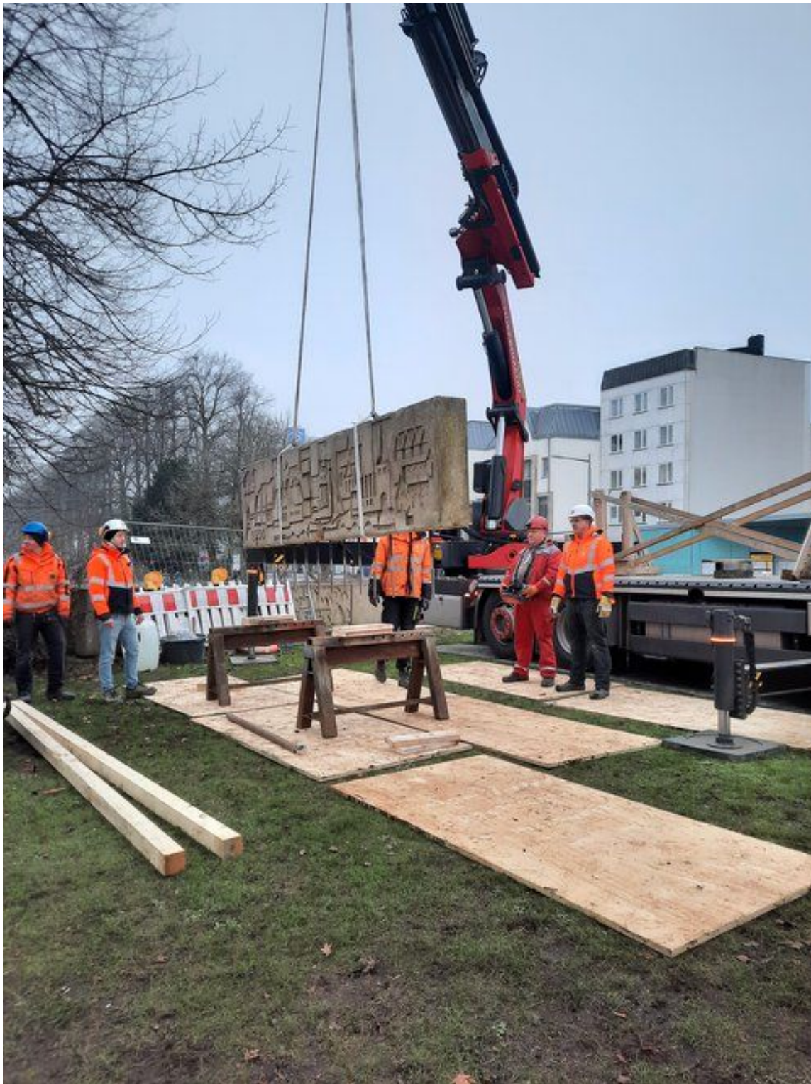
Das fehlende Teilstück des Kunstwerks von Georg Schmidt-Westerstede ist wieder an der Lappan-Kreuzung eingesetzt worden. Foto: Stadt Oldenburg
